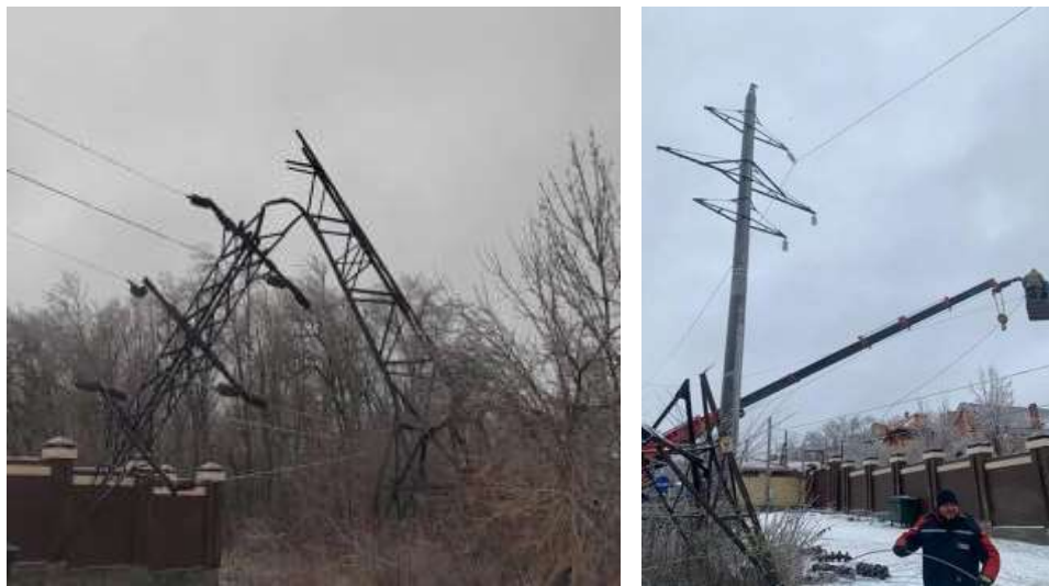
Рис. 1. Упавшая опора в результате ледяного дождя.
