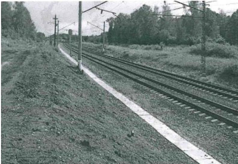
Рис. 7. Водоотводный лоток.
