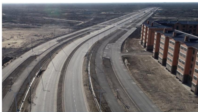
Рис. 4. Дорожное полотно левобережной части г. Кызылорды
