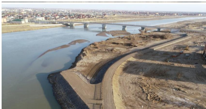
Рис. 1. Мост на левобережье Сырдарьи г. Кызылорды
