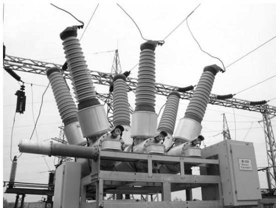
Рис. 1. Элегазовые выключатели
