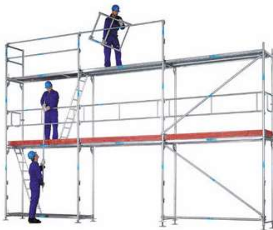
Рис. 10. процесс возведения строительных лесов, которая представляет собой практику под руководством учителя.
