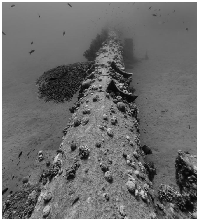
Рис. 1. Вид трубопровода на дне моря
