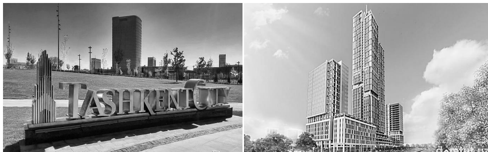
Рис. 1. Высотное здание при входе в Ташкент-СИТИ и жилой комплекс NEST ONE
